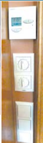
Lautstärke und Eingangsquellen können ganz einfach zentral per WLAN-Touch Screen (oben) oder vor Ort (rechts) geregelt werden
